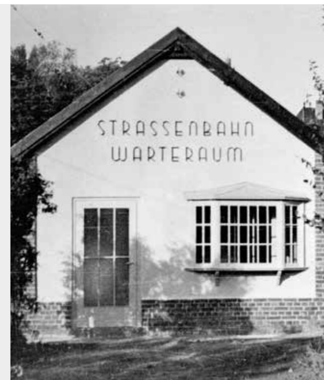
Neu erbauter „Straßenbahn-Warteraum“ an der Endstelle Landwehrschänke im Jahr 1949. Das aus Trümmersteinen gebaute kleine Gebäude umfasste auch einen Dienstraum für das Straßenbahn-Personal.
