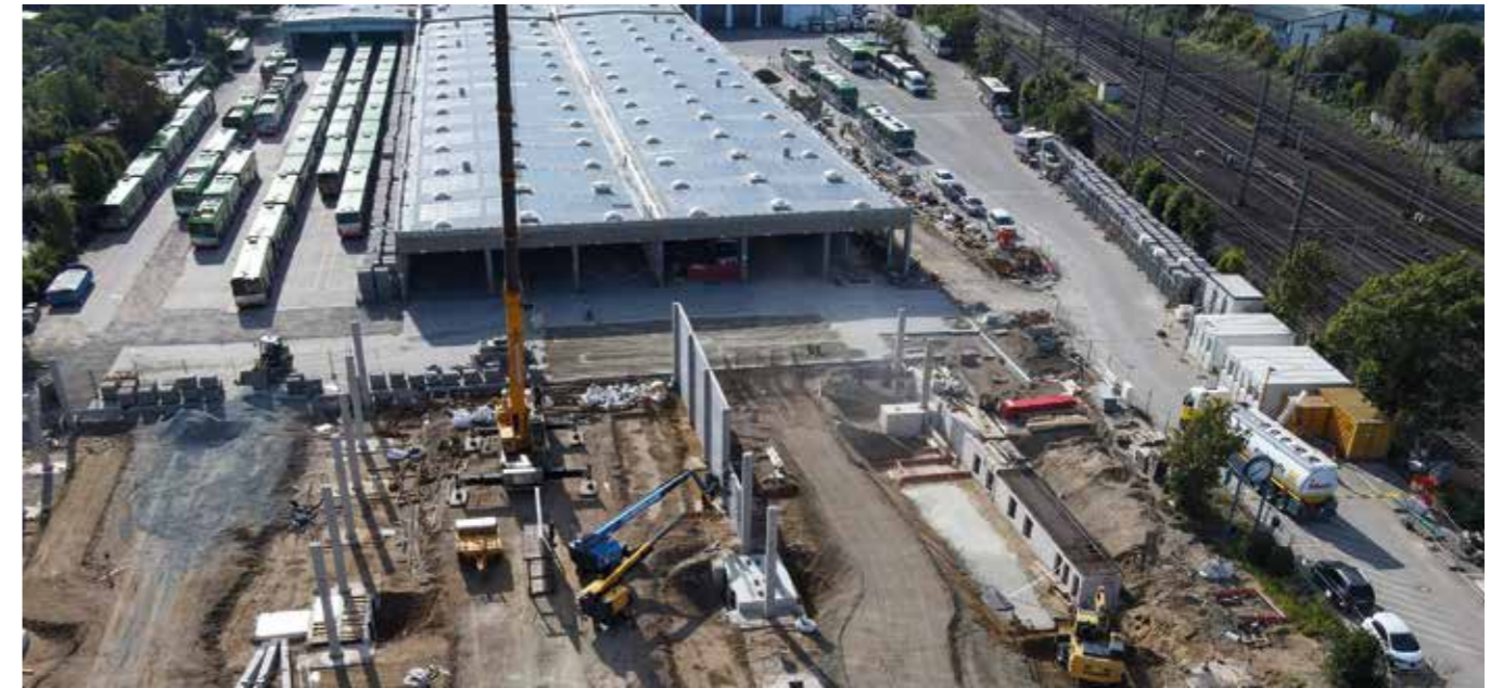
Luftaufnahme vom Stand der Bauarbeiten Ende September
